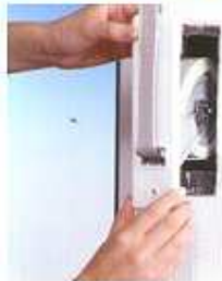
Smontare l'avvolgitore
